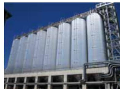
L'air de convoyage est refroidi à l'eau glacée et les tuyauteries, comme les silos, sont isolés thermiquement.
